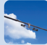
2 Amortiguador Stockbridge
